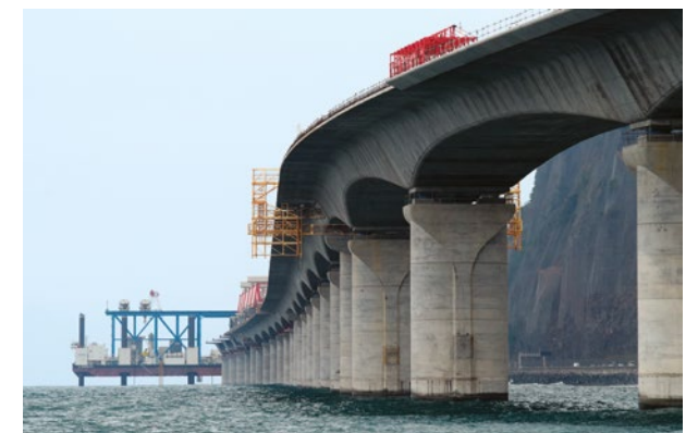
Viaduc NRL à La Réunion, dont les bétons ont été suivis par approche performantielle en anticipation de la révision de la norme NF EN206/CN et du fascicule de documentation associé FD P18-480
