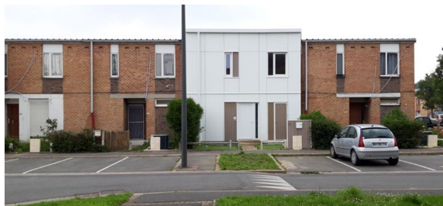
Façade rénovée par préfabrication des éléments. Wattrelos, France © Margot Pellegrino
